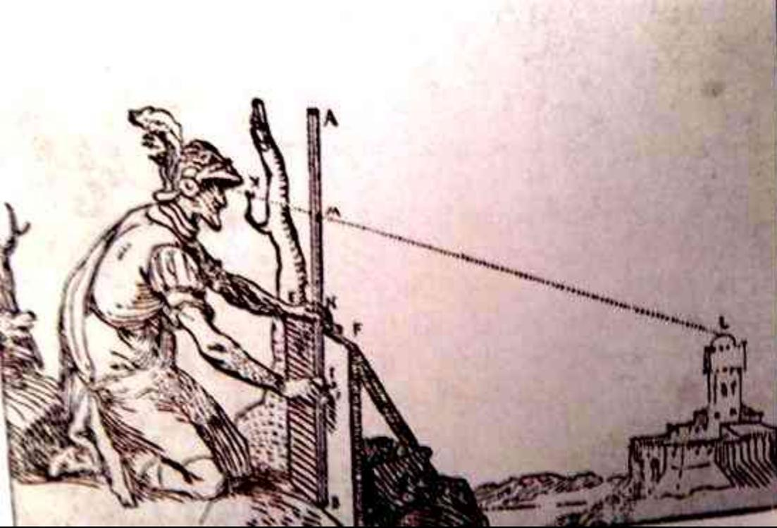
La prospettiva permise di avere il completo controllo della realtà, misurabile anche da distanza, come nell'esempio a sinistra: un soldato studia una fortezza nemica con un *prospettografo*, per valutare le distanze prima di attaccarla. In basso, uno strumento utilizzato per queste evenienze:
